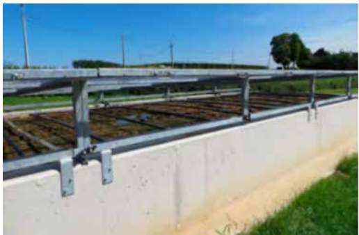
Figuur 31. Fytobak uit ter plaatse gestort gewapend en waterafstotend beton (bron: Protect'eau)
