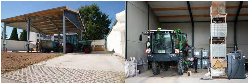
Figuur 23. Links: voorbeeld tunnelconstructie boven vul- en spoelplaats, (bron: pcfruit); Rechts: voorbeeld tenthal (bron: Profitent24)
