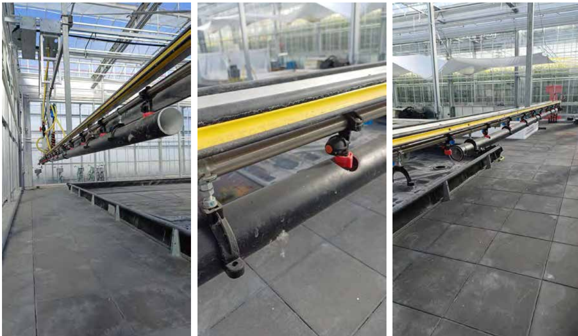
Figuur 46. Voorbeeld van spoelplaats voor overdekte teelten met vaste spuitboom met afvoerbuïs naar opvang van restvloeistoffen (bron: Inagro)
