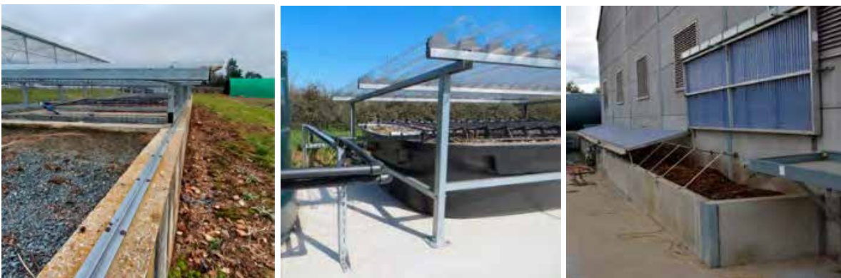
Figuur 39. Overzicht types dakconstructie: Links: Dakstelsel op rail; Midden: Dak op vastgeschroefd metalen frame; Rechts: Scharnierend dak (bron: Protect'eau)
